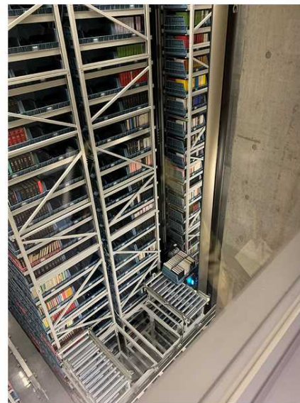
下の方でクレーンがコンテナを搬出中
